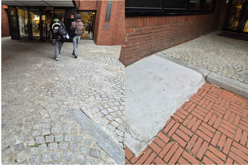
그림 7. 평탄화한 극장 입구 경사로 그림 8. 새로 만든 극장 입구 경사로
