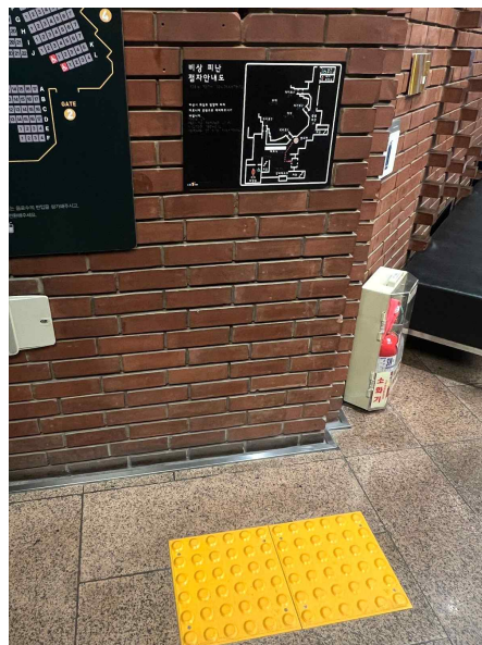
그림 9. 극장 내 점자블록
