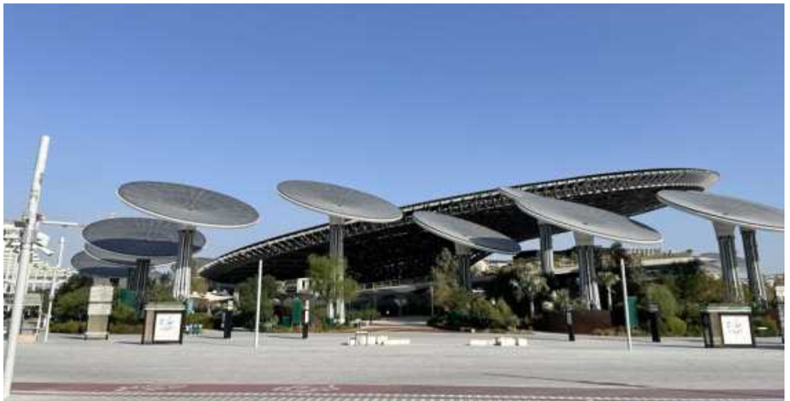
그림 54 EXPO City Dubai의 Sustainability 파빌리온에 설치된 태양광 패널, 직접 촬영.
